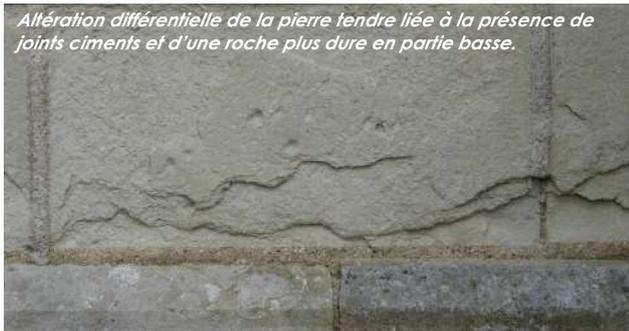
*Altération différentielle de la pierre tendre liée à la présence de joints ciments et d'une roche plus dure en partie basse.*
