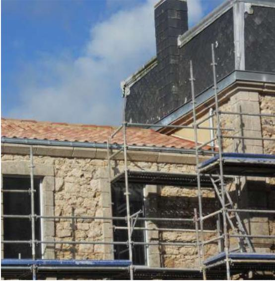
Les dégradations de l'enduit peuvent être dues à l'humidité (infiltrations, remontées capillaires) ou aux efflorescences (salpêtre, mousses, lichens...).
