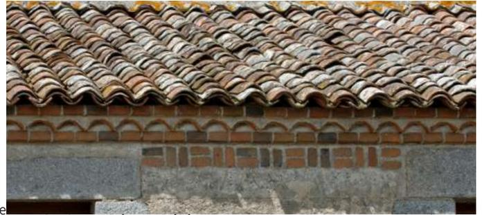
la tuile de rive étant l'élément courant de la couverture (tuiles du dessous) ou l'élément couvrant (tuile du dessus) et non une tuile à rabat comme dans les constructions plus récentes.
